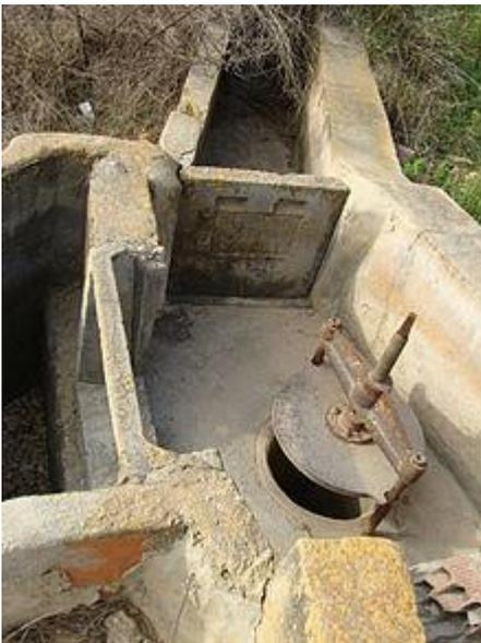
Sistema de riego abandonado, con acequias y compuertas para la distribución. El agua venía por tuberías desde un motor que bombeaba el agua desde un pozo situado a un km de distancia. Sustituido a fines del siglo XX por el bombeo a un embalse que distribuye el agua con el sistema de riego por goteo.
